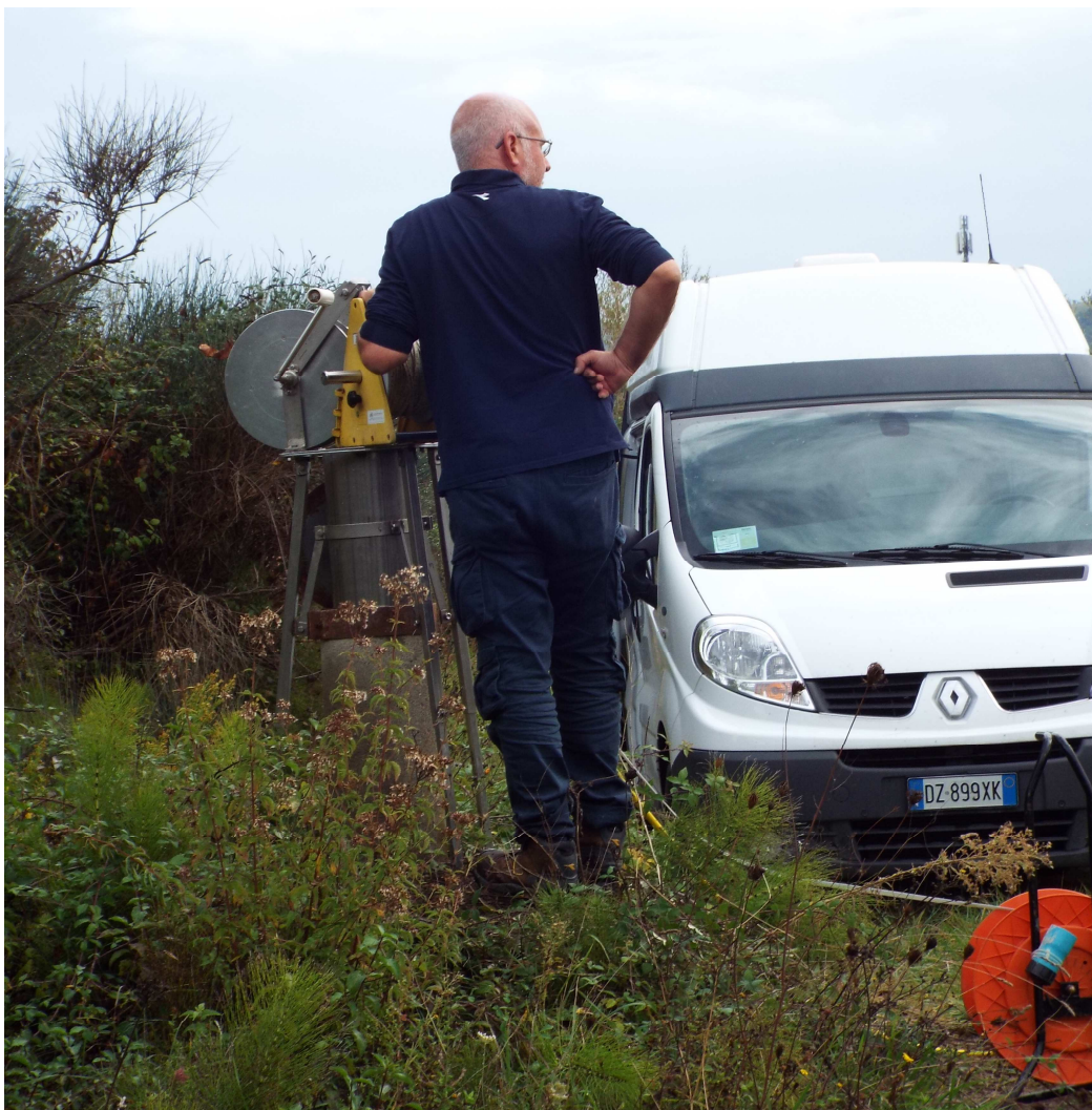
Fig.4: Operazioni di approntamento della colonna di mandata sul punto ZIF3.
